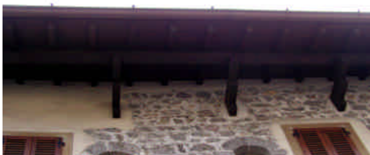
Numerosi sono i casi in cui, in presenza di forti aggetti, la struttura della gronda viene rinforzata da mensole o puntoni inseriti nella muratura perimetrale a sostegno di una trave longitudinale su cui si vanno ad appoggiare i travetti.
