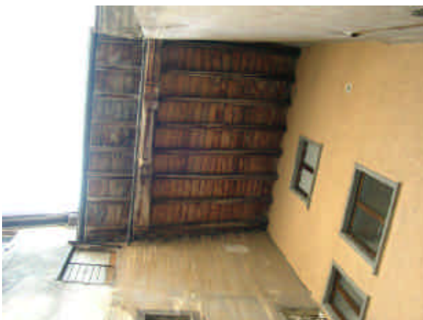
Numerosi sono i casi in cui, in presenza di forti aggetti, la struttura della gronda viene rinforzata da mensole o puntoni inseriti nella muratura perimetrale a sostegno di una trave longitudinale su cui si vanno ad appoggiare i travetti.
