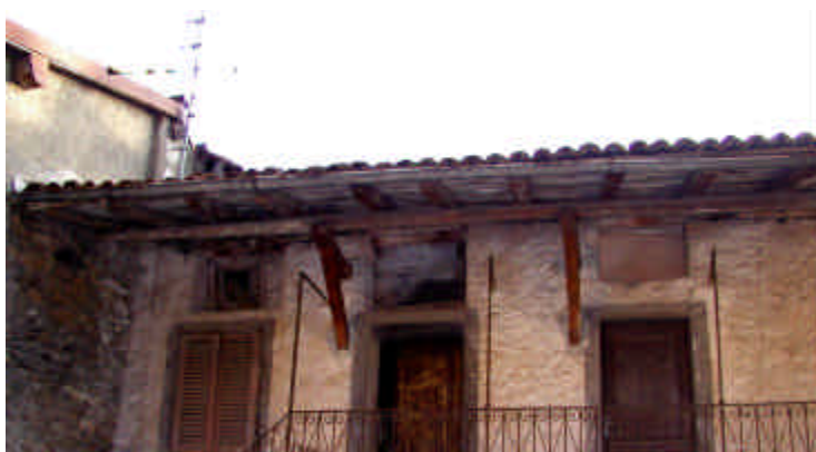
Numerosi sono i casi in cui, in presenza di forti aggetti, la struttura della gronda viene rinforzata da mensole o puntoni inseriti nella muratura perimetrale a sostegno di una trave longitudinale su cui si vanno ad appoggiare i travetti.
